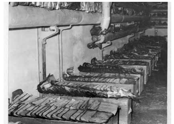
Trockenlegung im Heizkeller
