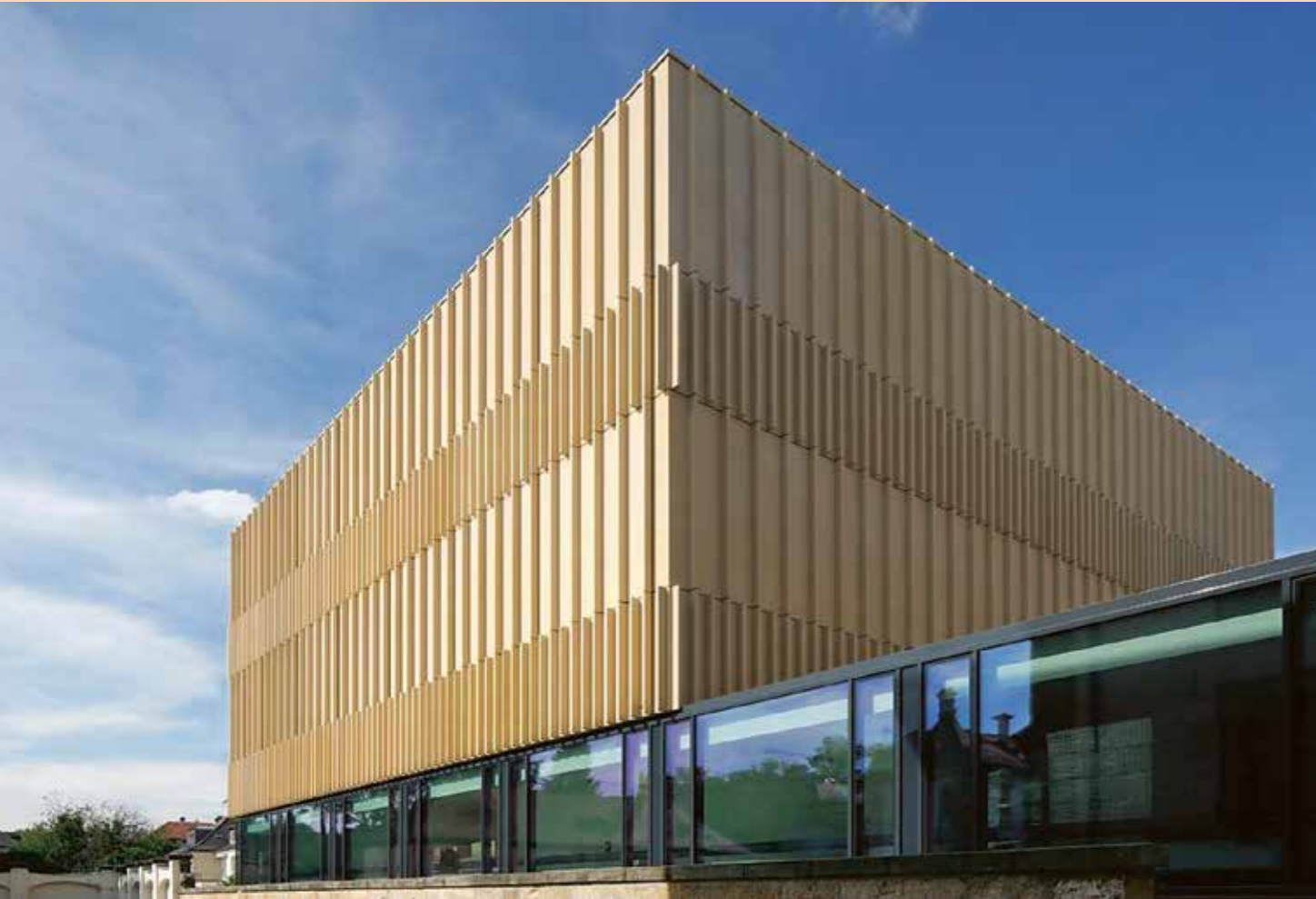
Erweiterungsbau Staatsarchiv Bamberg.
