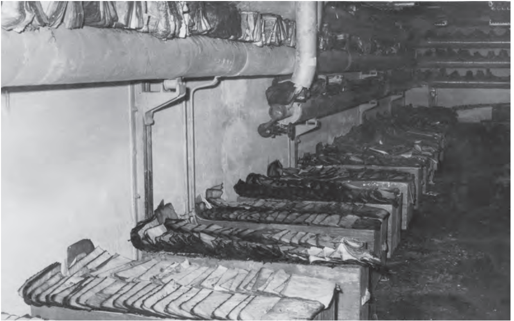
Abb. 5: Lufttrocknung von Einzelblättern im Heizungskeller des Bayerischen Hauptstaatsarchivs (damals noch Arcisstraße 12) (Bayerisches Hauptstaatsarchiv, NL Zittel, Bernhard 7, Abb. 63).
