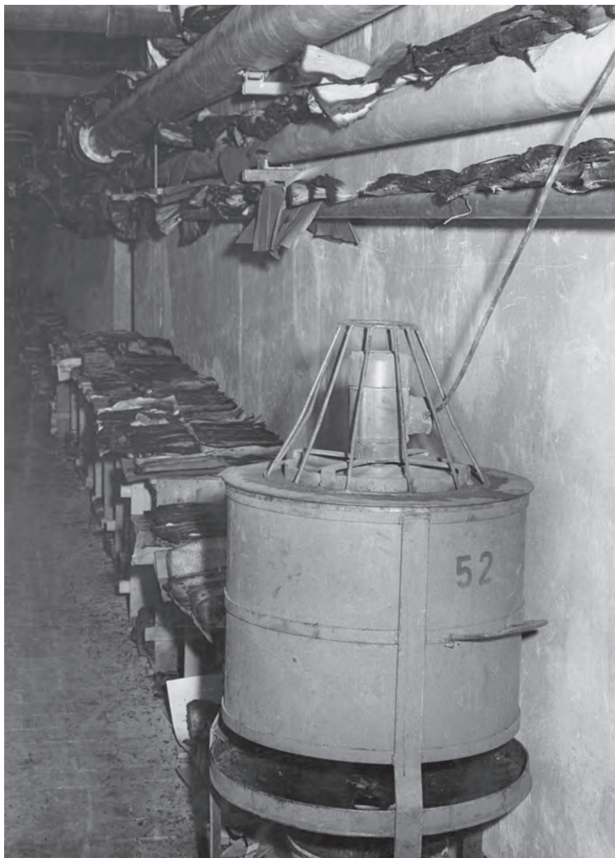
Kat.-Nr. 4.2a Luftentfeuchter in Betrieb.
