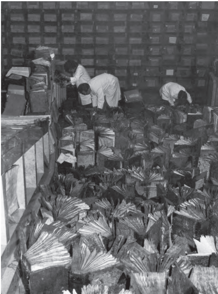
Abb. 4: Lufttrocknung von aufgefächerten Bänden (Bayerisches Hauptstaatsarchiv, NL Zittel, Bernhard 7, Abb. 46).
