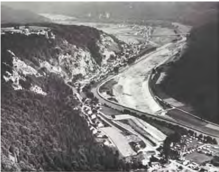
Von rechts nach links der 1,2 km lange Teilabschnitt der Wasserstraße jenseits der Flutung im Oktober 1978, die im Bau befindliche Umgehungsstraße abseits des alten Altmühlbettes errichtet wurde und ein zwei Kilometer langes, gestörtes Gelände AUSENDRUM und der Ort Neumessing mit der Burg Randeck, im Hintergrund der Ort Altmühl und die neue Brücke im Zuge der künftigen Kreisstraße Kirchheim-Parzen. Die Untersuchungen mehrerer Hochwasserspitzen über Form und Bauart einer Fußgängerbrücke zwischen Neumessing und der rechten Talsohle sind von der RMD in Auftrag gegeben.
