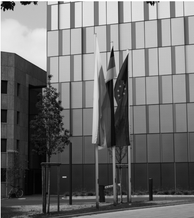
Bestandsbau, Glasfuge und Anbau des Staatsarchivs Augsburg (Foto: Richard Helfrich, Staatsarchiv Augsburg).
