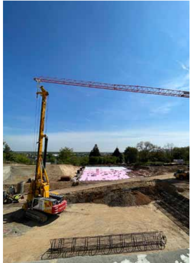
Blick in die Baugrube für den Neubau; Foto: Staatliches Bauamt Würzburg.
