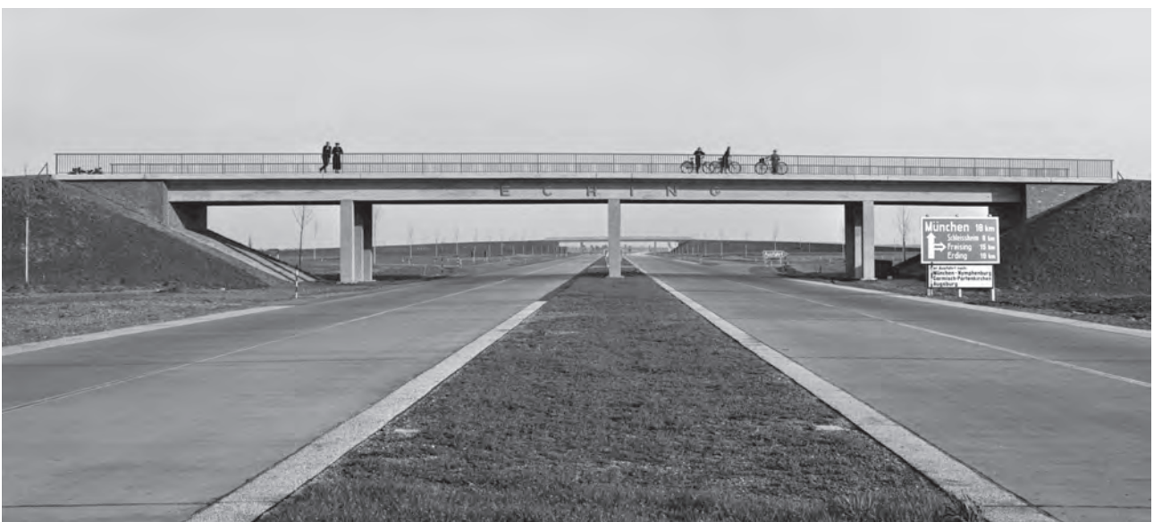
Heutige Autobahn A 9 im Bereich der Anschlussstelle Eching im April 1939 (Staatsarchiv München, Fotobestand Autobahndirektion Südbayern, Bild 20.835).
